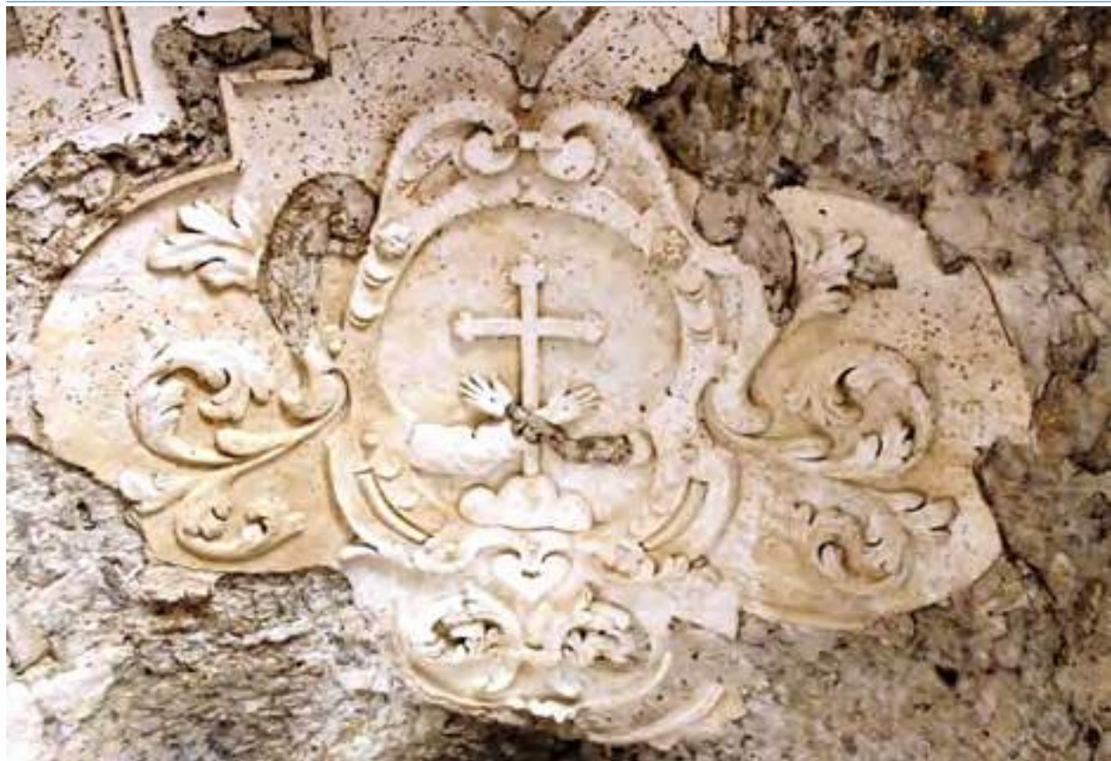
Decorazione a stucco rinvenuta durante il corso dei lavori
