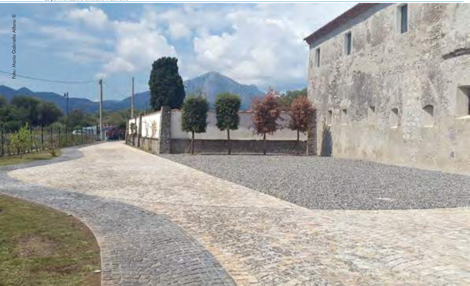
La pavimentazione antistante il convento
