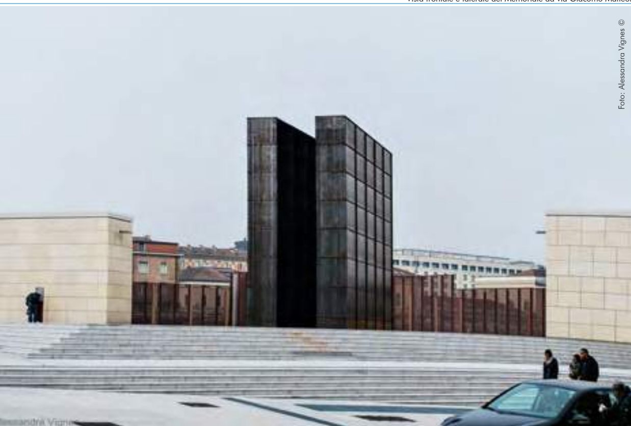
Vista frontale e laterale del Memoriale da via Giacomo Matteotti
