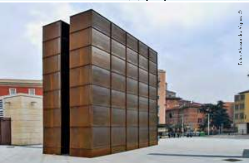
Vista laterale dei blocchi in corten, le sporgenze segnano la scansione interna dei vari piani
